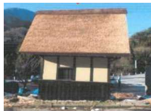
小屋屋根茅葺工事
