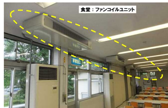
食堂ホール の空調補助として
