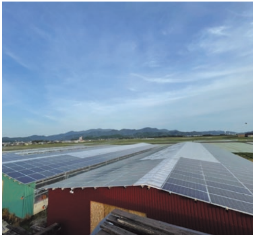
ソーラーシェアリングハイブリットビニールハウス
