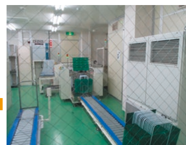
新工法取出口
