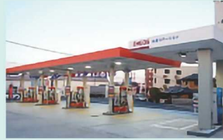
大阪府茨木市 〔JXTG エネルギー (株) (オンサイト方式(SS 一体型))〕
